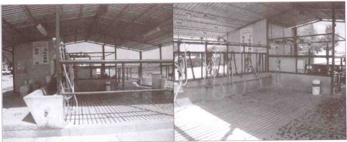
Figura 35. Sala en parada convencional.
